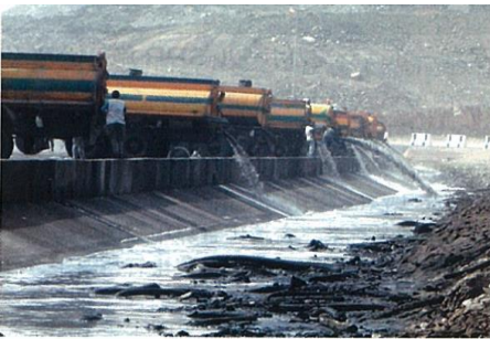
下水放流状況（サウジアラビア）
